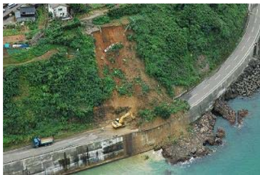
写真-5. 28 海食崖が肩部から崩壊 朝日航洋株提供
