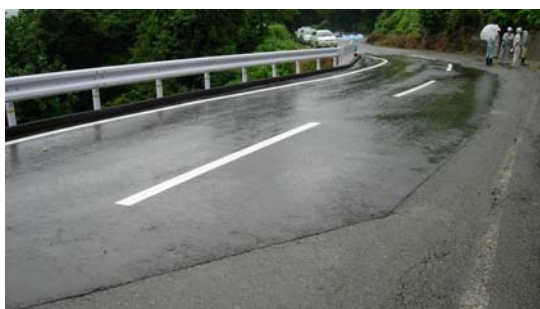
写真-6.9 出雲崎町小釜谷中永線の道路拡幅EPS盛土 (No. 2) 路面状況 (路面・壁面ともに良好で変状無し)
