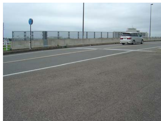
写真-6.19 国道8号半田跨線橋橋台背面E P S盛土 路面状況 (橋台とE P S盛土接合部での段差・目開き無し)
