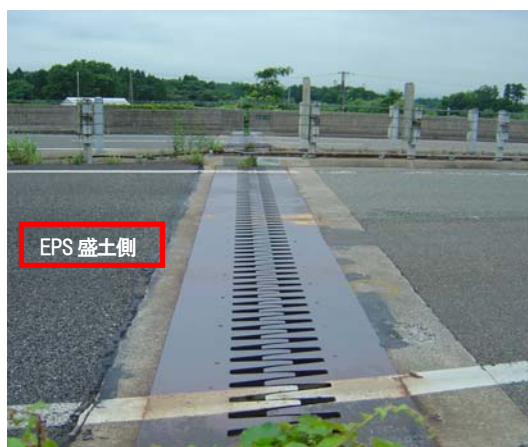
写真-6.21 橋台背面EPS盛土による路面状況 （橋台とEPS盛土接合部での段差・目開き無し） （路面・壁面ともに良好で変状無し）
