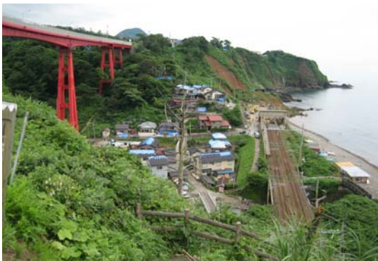
写真-5. 26 J R信越本線青海川駅舎の斜面崩壊 ( 国道8号の橋梁・青海川集落・青海川駅)
