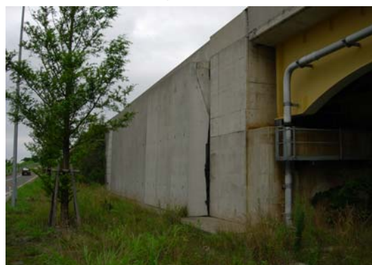
写真-6.23 国道18号三田地区橋台背面EPS盛土 A1側壁面状況 （路面・壁面ともに良好で変状無し）
