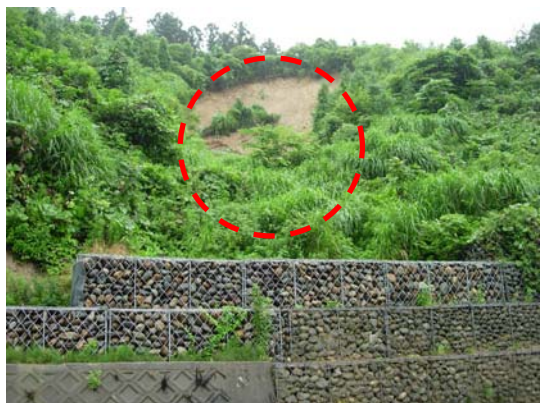
写真-6.10 EPS盛土No. 2 EPS盛土背面地山の斜面崩壊状況
