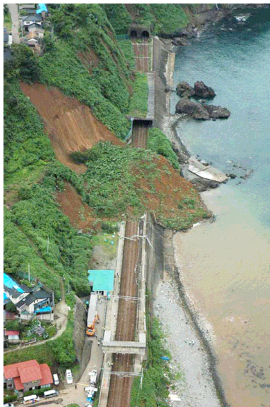
写真-5. 25 J R信越本線青海川駅舎の斜面崩壊 ( 斜面崩壊は、幅約50m、高さ90m程度。奥にロックシェ ッド、トンネルが確認される ) 朝日航洋株提供
