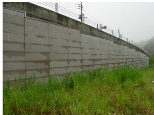
写真-6.1 宮路町の国道351号道路拡幅EPS盛土壁面状況
