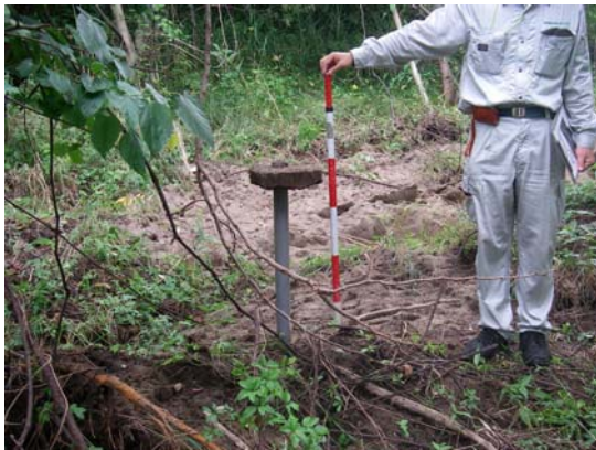
写真-5.18 鯖石川右岸堤防基礎地盤の液状化による沈下（沈下推定量80cm）
