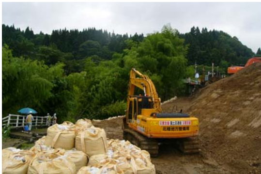
写真-5.2 長岡市大積線千本町地先の国道8号復旧状況
