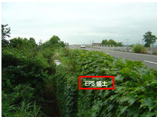
写真-6.20 北陸自動車道保倉川の橋台背面EPS盛土壁面状況
