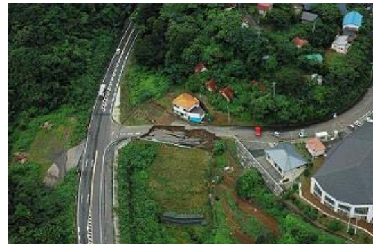
写真-5. 29 国道8号沿いの谷埋め盛土の崩壊 朝日航洋株提供
