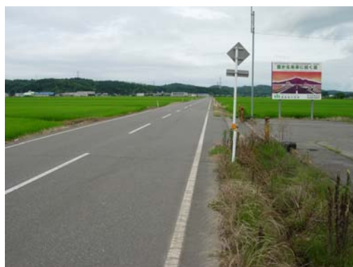
写真-6.13 刈羽村広域営農団地農道のEPS盛土
