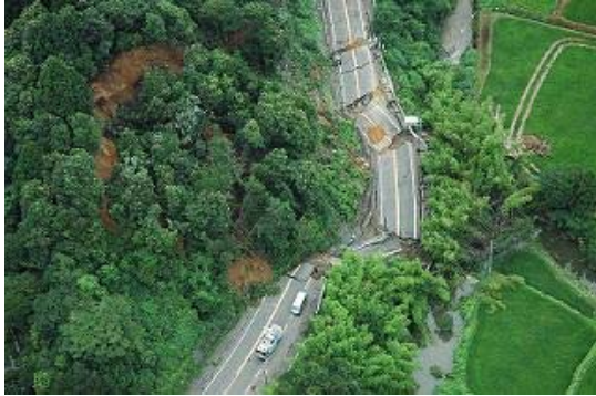
写真-5.1 長岡市大積線千本町地先の国道8号斜面崩壊 朝日航洋（株）提供
