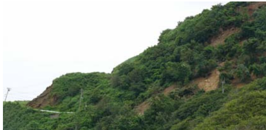
写真-5.33 米山町の斜面崩壊状況
