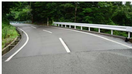
写真-6.4 出雲崎町小釜谷中永線の道路拡幅EPS盛土 (No.1) 路面状況 (路面・壁面ともに良好で変状無し)
