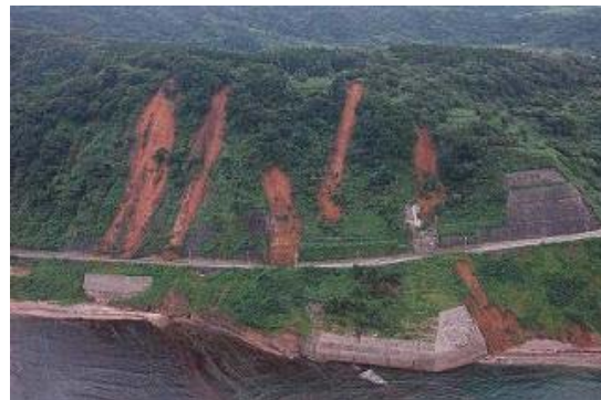
写真-5.5 国道352号椎谷観音岬地区の斜面崩壊 （表層崩壊が数箇所にて発生）朝日航洋（株）提供
