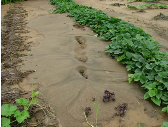
写真-5. 24 松波地区に液状化による噴砂跡 【 青海川地区 】
