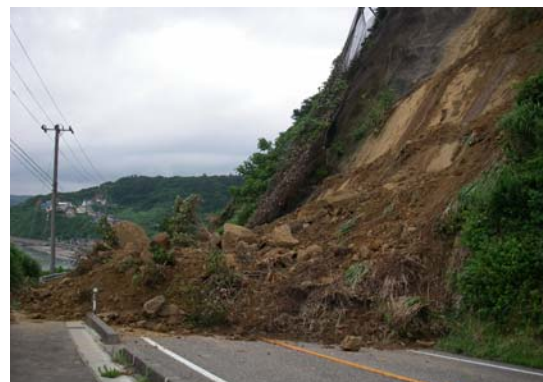
写真-5.6 国道352号椎谷観音岬地区の斜面崩壊
