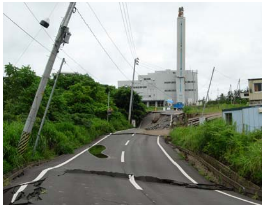
写真-5.19 鯖石川右岸堤防に隣接する道路の変状
