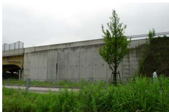
写真-6.22 国道18号三田地区橋台背面EPS盛土 A2側壁面状況
