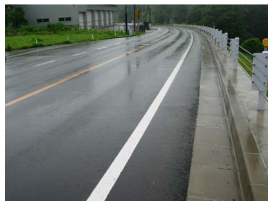
写真-6.2 宮路町の国道351号道路拡幅EPS盛土路面状況 (路面・壁面ともに良好で変状無し)
