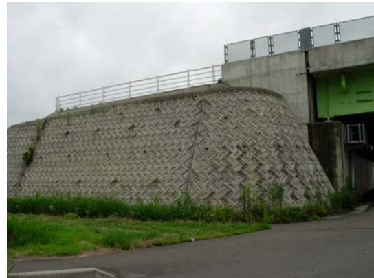
写真-6.17 国道8号半田地区跨線橋橋台背面E P S盛土 (両直型E P S盛土の両側に施されている土盛土)
