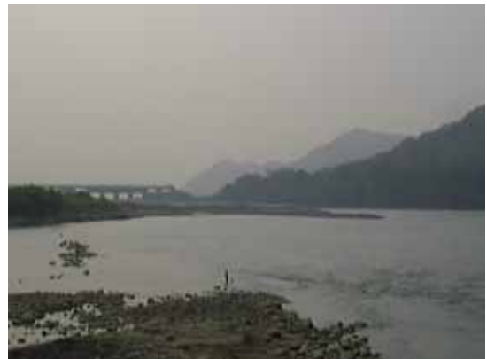
写真-6.9 石岡ダムの崩壊状況（向かって左側が隆起）
