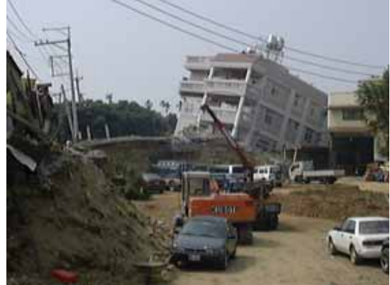
写真-6.8 一江橋近傍で確認された地震断層
