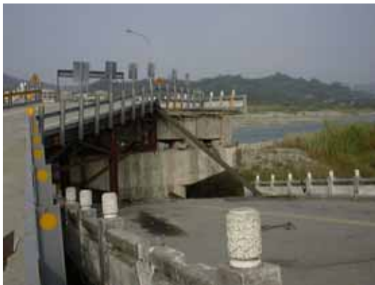
写真-6.6 長夷大橋の応急復旧状況
