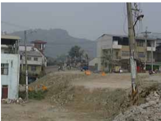
写真-6.12 大杭花園城付近の道路（隆起量3m）
