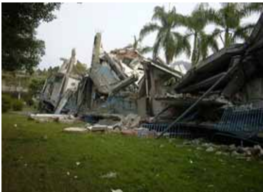
写真-6.2 地震断層により被害を受けた小学校 (霧峰市街の小学校)
