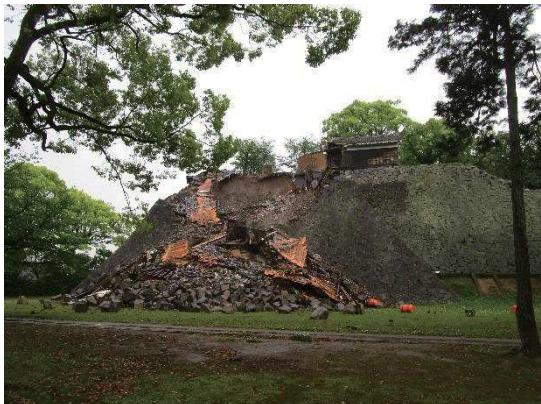
写真-2.6 熊本城の石垣の被害状況
