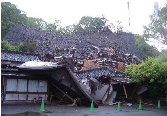
写真-2.7 熊本城の石垣の崩壊による熊本大神宮の倒壊
