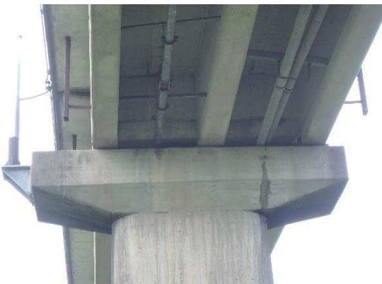
写真-3.3.6 田口橋の桁の移動
