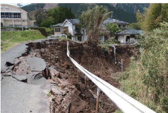
写真-2. 14 南阿蘇村河陽におけるすべりによる崩壊
