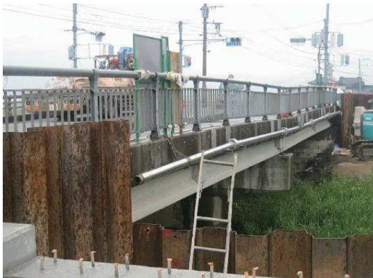
写真-3.3.4 惣領橋の橋脚の沈下
