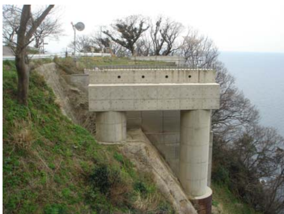
写真-6.9 輪島浦上線の道路拡幅E P S盛土
