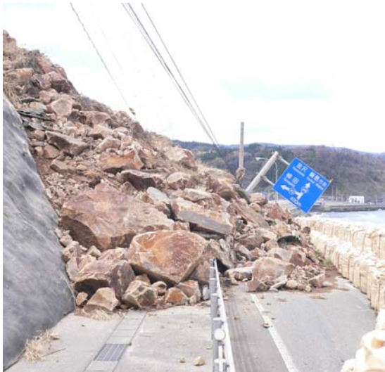
写真-5.6 輪島市大川町地内の国道249号の斜面崩壊
