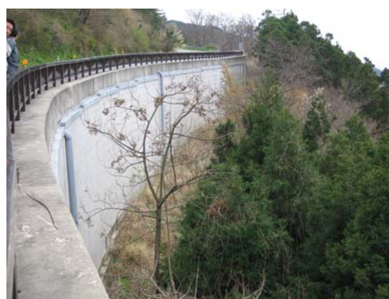
写真-6.12 輪島浦上線の道路拡幅E P S盛土
