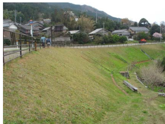
写真-6.5 輪島市深見町地区 国道249号のE P S盛土の全景
