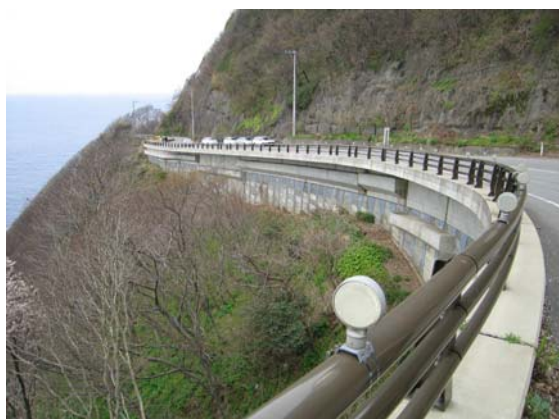
写真-6.7 輪島浦上線の道路拡幅E P S盛土の全景
