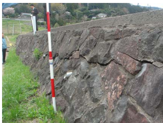
写真-6.3 輪島市白米町千枚田地区 国道249号のE P S盛土の壁面状況
