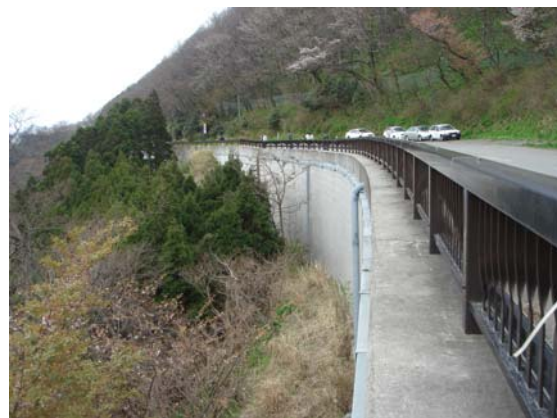
写真-6.11 輪島浦上線の道路拡幅E P S盛土の全景
