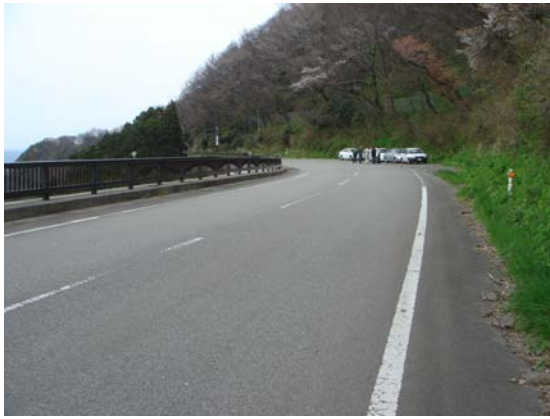
写真-6.13 輪島浦上線の道路拡幅EPS盛土 路面状況：路面は良好で変状無し
