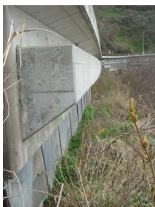
写真-6.8 輪島浦上線の道路拡幅E P S盛土
