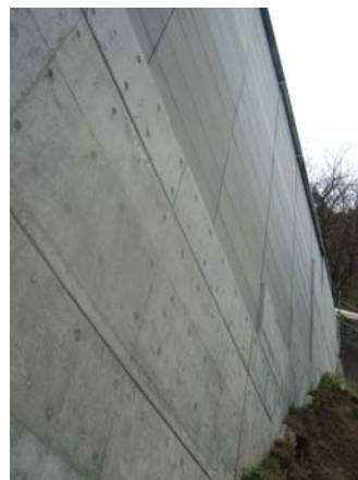
写真-6.10 輪島浦上線の道路拡幅E P S盛土
