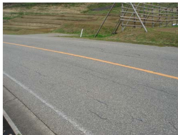
写真-6.4 輪島市白米町千枚田地区 国道249号のE P S盛土の路面状況 (路面は良好で変状無し)
