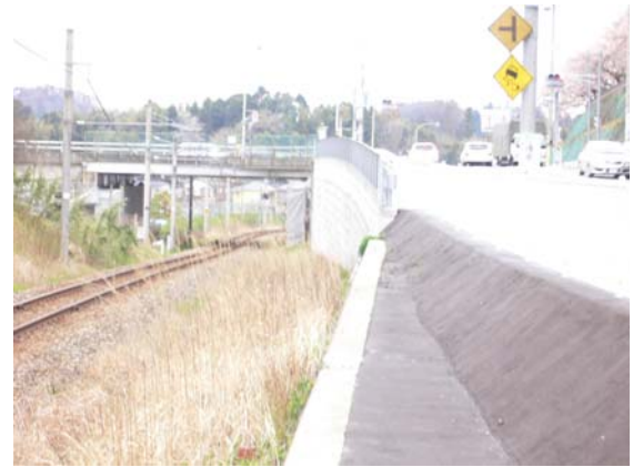
写真-6.16 七尾和倉線の市道でのEPS盛土の全景
