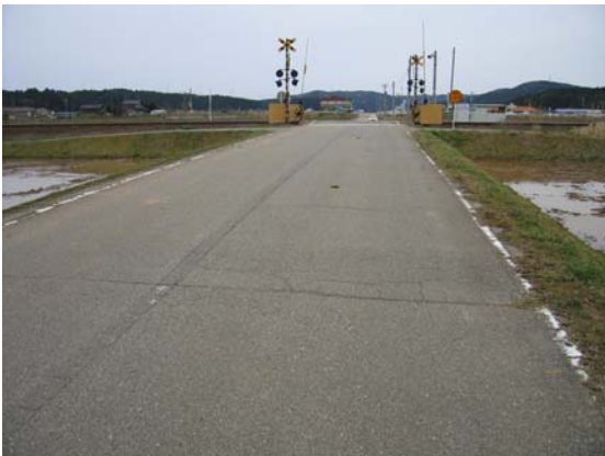
写真-6.14 七尾市農道(中島町) EPS盛土の路面状況
