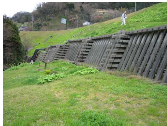
写真-6.6 輪島市深見町地区 国道249号のE P S盛土ののり面状況 (路面・のり面ともに良好で変状無し)
