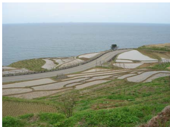
写真-6.2 輪島市白米町千枚田地区 国道249号のE P S盛土の全景
