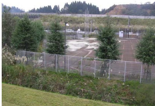
写真-5.37 関越道：隣接駐車場内の噴砂現象
