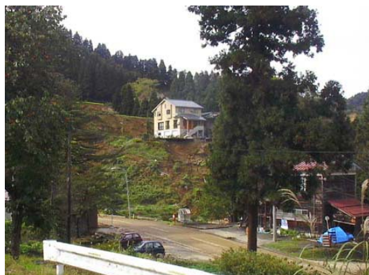
写真-5.32 民家下部斜面の崩壊
