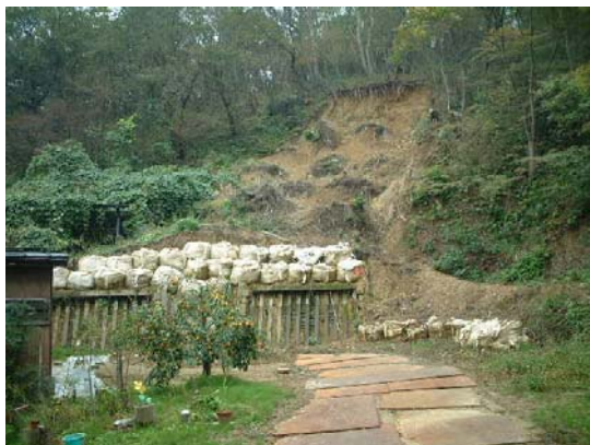
写真-5.2 見附市内建屋背面斜面のすべりによる崩壊
