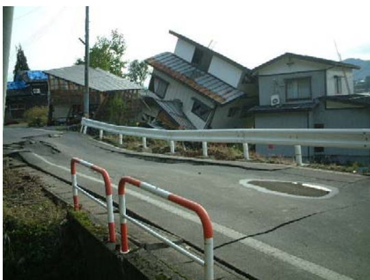
写真-5.29 川口地区の地すべりによる道路・家屋変状
