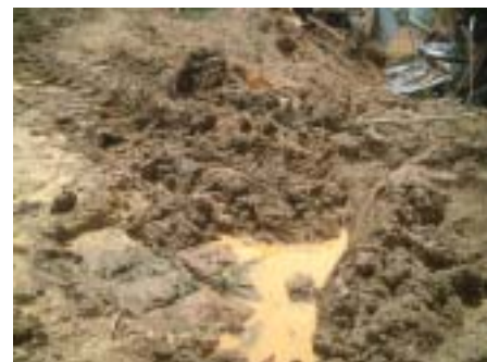
図-6.13 緩斜面の土砂崩れの土砂の状況
