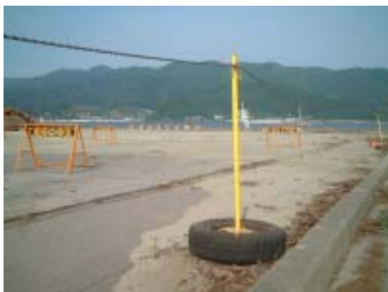
図-6.15 大船渡港野々田ふ頭岸壁の地震被害状況
