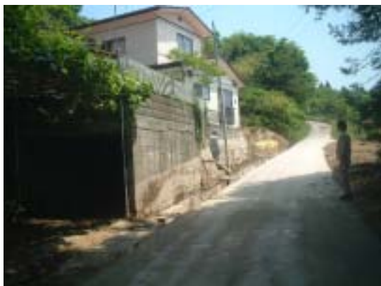
図-6.9 近隣住宅の土砂流出跡 (路上の土砂は排土されている)
