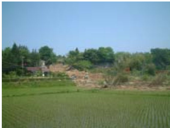
図-6.8 水田から見た土砂災害の全景
