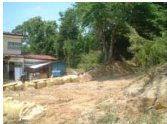
図-6.12 緩斜面の土砂崩れの応急復旧状況
